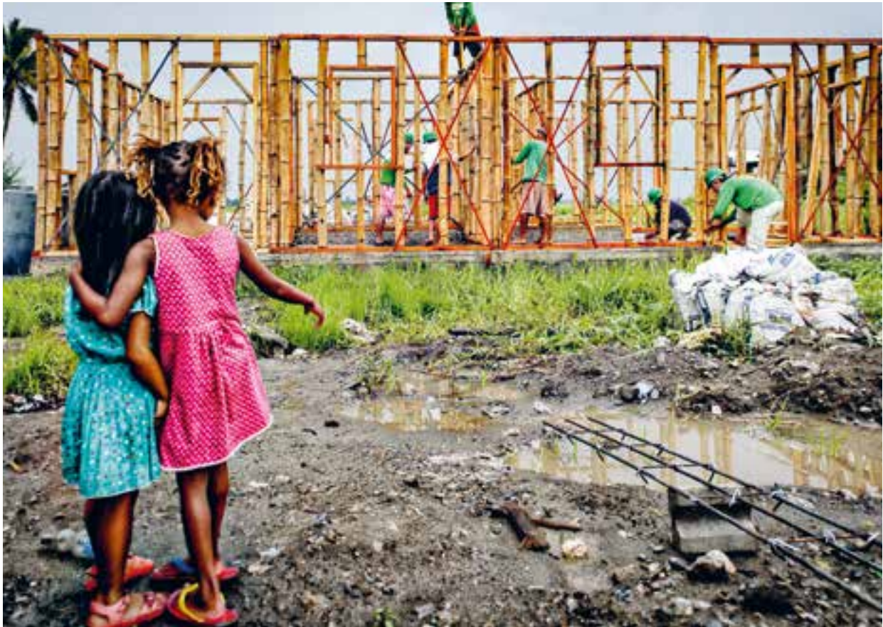
Katastrophensichere Bauweise, die nachhaltig und bezahlbar ist: Bambushäuser auf den Philippinen.
